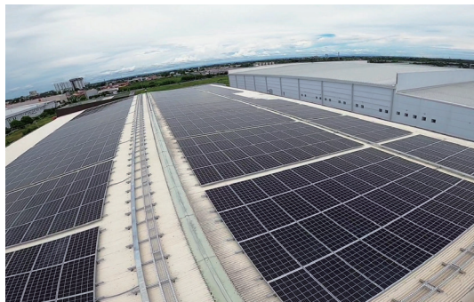
セブ工場での太陽光パネルの設置
